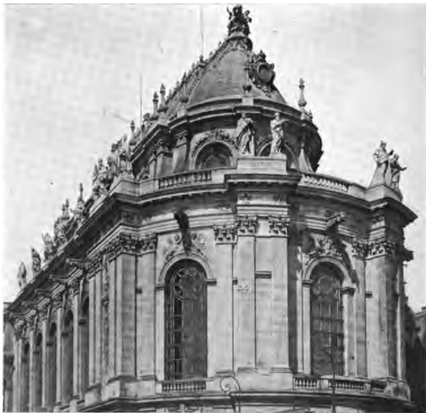
Fig. 93. — Fenêtres hautes à la chapelle du château de Versailles. Archivoltes soutenant des tympans ornés.
